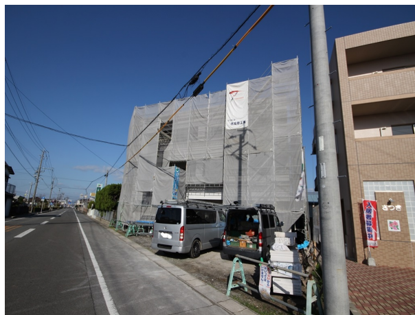
現在建築中 (H30.12.24撮影)
