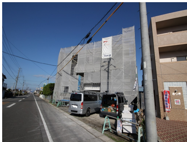
現在建築中 (H30.12.24撮影)
